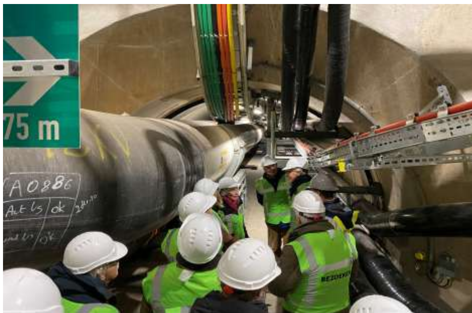
Tunnelstraat, met nog eens 30 man erdoor, onder 'hoge druk'...
